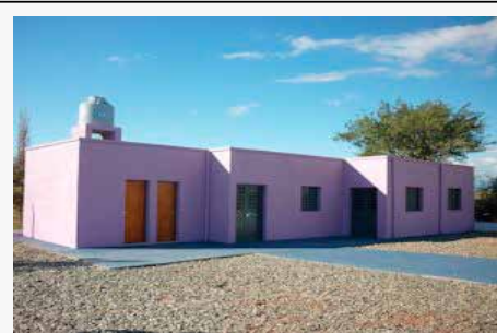
AMPLIACIÓN INAUGURADA EL Este nuevo módulo está compuesto por dos aulas y baños totalmente equipados.-
